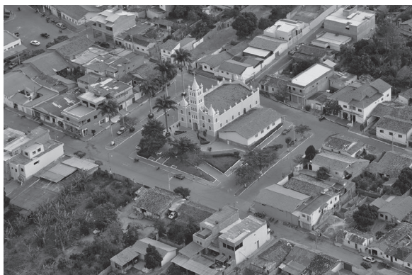
Vista aérea da Igreja Matriz de São João Batista
