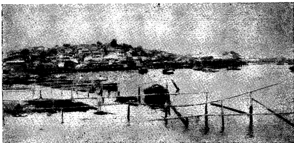
Vista geral da Quinta do Caju: notar o apinhado das casas e a enorme extensão do varal para secar as rêdes.
