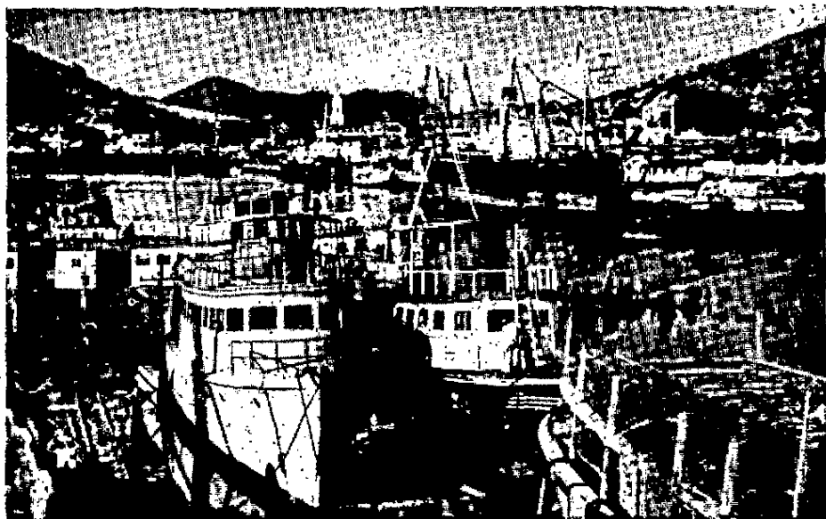
rabalho no estaleiro Cruzeiro do Sul. Lanchas da companhia estão sendo reparadas, enquanto está sendo construído um navio balizador.
