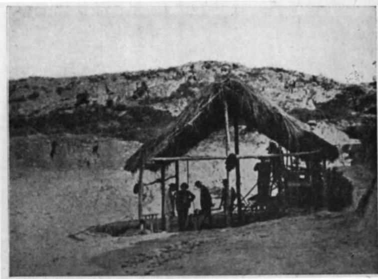
Fig. 21 — A depressão de Serrinho, rasa e sobre o quartzito do Caraça, que foi parcialmente entulhada pelo conglomerado diamantífero. O conglomerado e um caulim extremamente branco são vistos no fundo da escavação. As operações finais de lavagem para a obtenção dos diamantes são feitas na batela, sob a proteção do barracão de palha.
