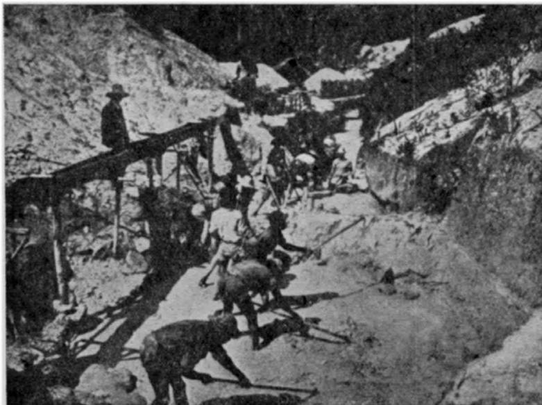
Fig. 25 — Mistura da massa de argila diamantífera e cascalho.
