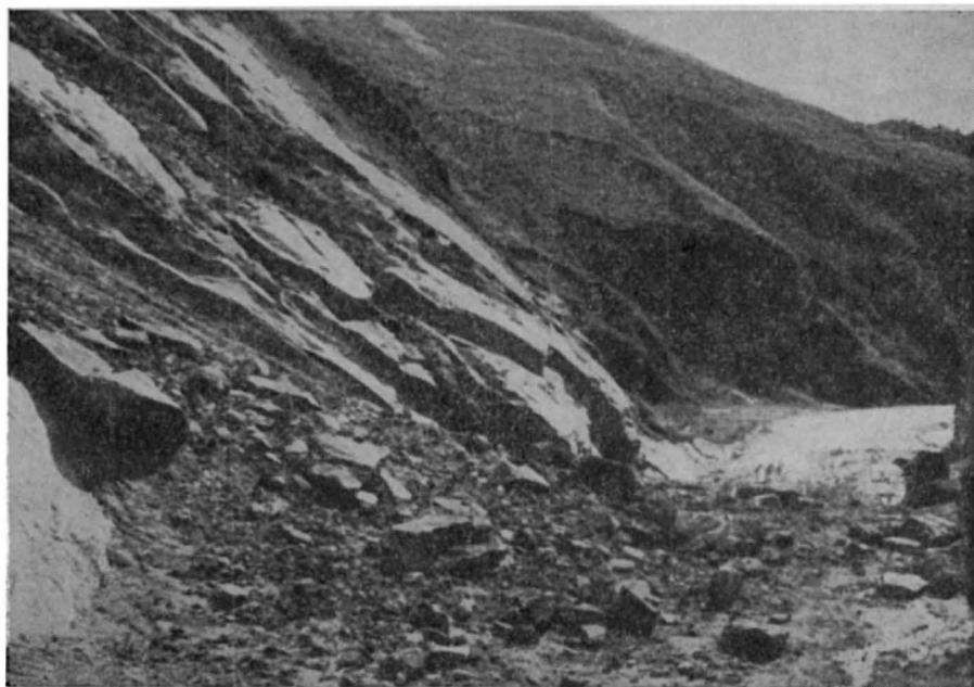
Fig. 4 — Gnaiss biotita do arqueano da serra do Mar, na estrada de rodagem Rodeio a Taireté (Ex-Paracambi). Deslizamento de solo e rocha decomposta em função da embibição da argila e também da inclinação das camadas. (Foto Alfredo J. P. Domingues).
