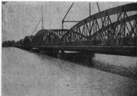
Foto n.º 41 — Ponte construída sobre o rio Senegal na cidade de São Luís. Na parte central por ocasião da passagem dos navios ela é aberta segundo dois eixos verticais.
