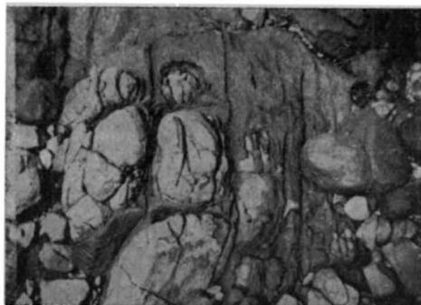
Foto n.º 21 — Processo de decomposição do basalto, atacado pela hidratação, ao longo das diaclases.
