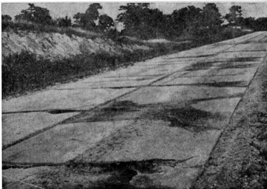
*Na fotografia o pavimento está seriamente fraturado onde um corte foi feito em argila esquistosa. Este é um contraste bem evidente comparado com o pavimento ao fundo, o qual assenta num solo mais firme. Um pavimento mais espesso ou uma base mais cuidadosamente preparada, talvez tivesse evitado estas fraturas, ou talvez uma modificação no trajeto tivesse evitado por completo esta argila esquistosa.*
