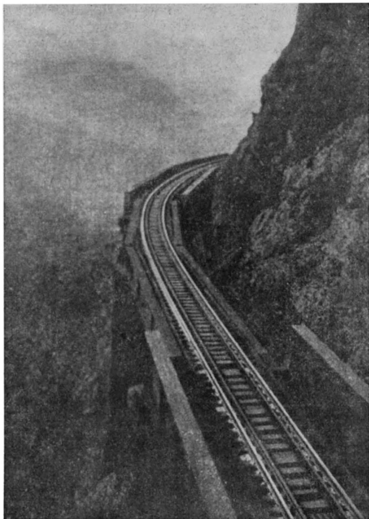
Fig. 6 — Viaduto Presidente Carvalho, com 84 metros de comprimento, na encosta da montanha.
