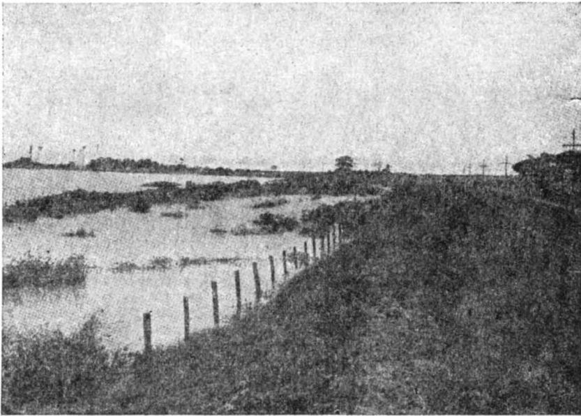
Fig. 16 — Dique de argila, à margem direita do Paraíba, a jusante de Campos; trabalho do Departamento Nacional de Obras de Saneamento, que protege a planície das cheias do rio. Ao longe, as palmeiras de Atrises e a chaminé da destilaria de Martins Laje, do I.A.A.
