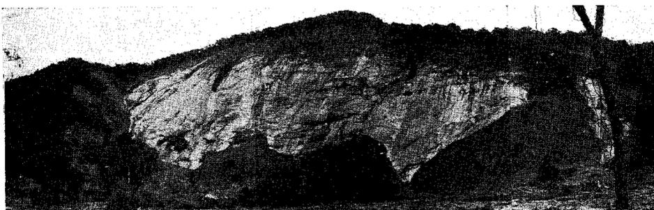
Fig. 10 — Um dos maiores escorregamentos ocorreu na face sudeste do morro do Jaraguá, fazendo aflorar os gnaisses e soterrando parcialmente taludes de detritos mais antigos. Nota-se à esquerda a espessura do manto de alteração.
