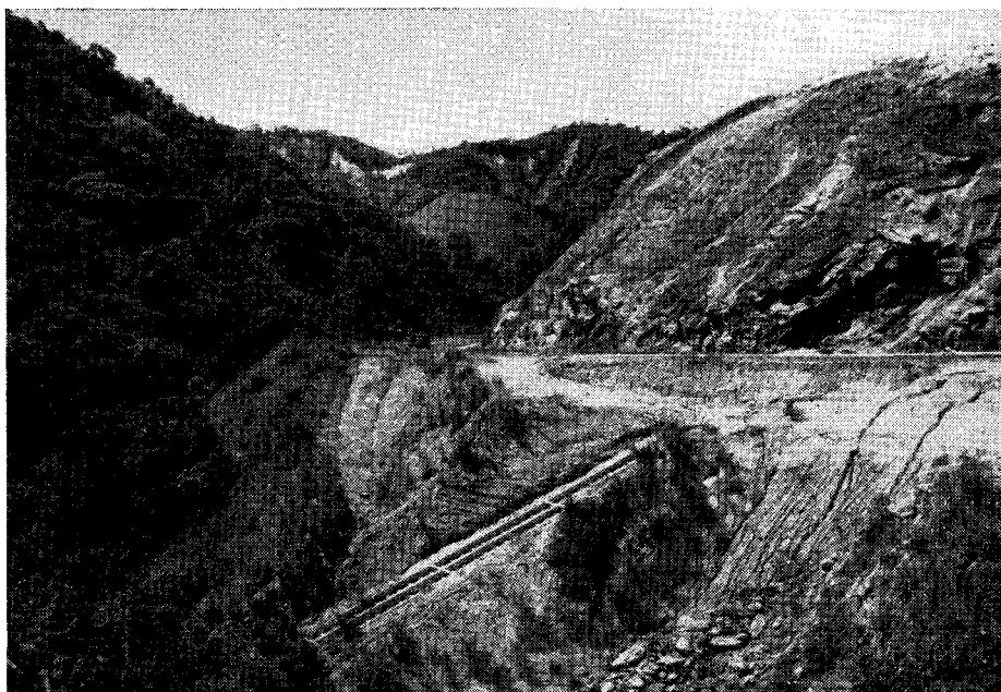
Foto 16 — Aspecto de uma das obras executadas para atenuar os efeitos das águas pluviais. Tais obras são necessárias a fim de evitar a intensificação da erosão que ocorre nas encostas muito íngremes.
