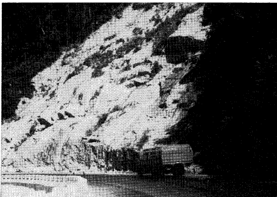
Foto 14 — Aspecto das obras de sustentação no km 62 da pista de descida. As diáclases curvas originam placas em torno das quais a umidade atua, podendo contribuir para a queda dessas placas. Para que tal não aconteça elas são fixadas à massa rochosa do substrato através de tirantes de aço.
