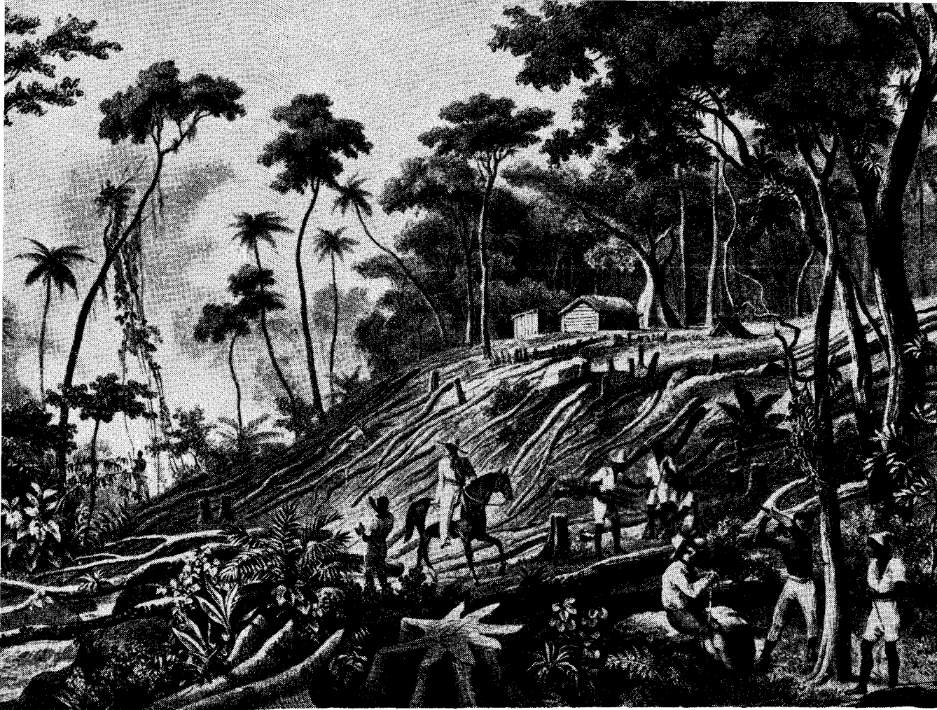
Fig. 4 — Derrubada para a formação de um cafézal no interior fluminense, no século passado. Notar a casa provisória do fazendeiro. (Desenho de RUGENDAS). ( O Homem e a Serra , p. 144, fig. 55)
