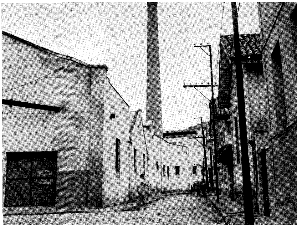
Foto 3 — Tecelagem Pôrto Novo, em Além-Paraíba, exemplo de fábrica instalada na antiga fase de implantação industrial, que também pode ser evocada em alguns traços urbanos, como a rua estreita e tortuosa observada na fotografia.
