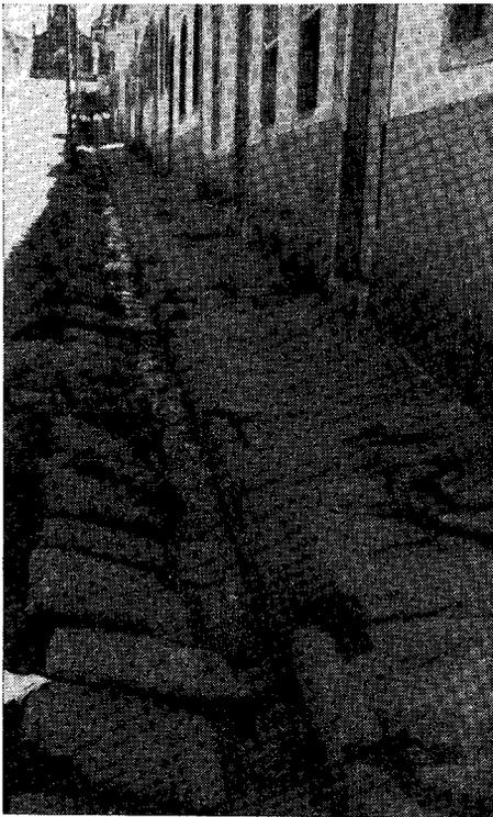
Foto 46 — Passeios e sargetas de São Luís. Essas lajes já foram usadas como calçamento das principais ruas da cidade (foto P. Petrone).
