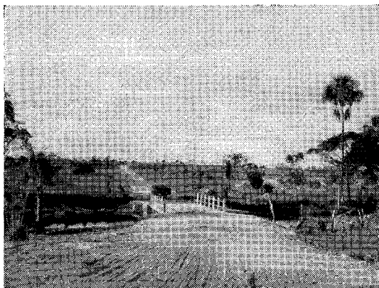
Fig. 17 — Sobre o igarapé Uai Grande foi construída uma boa ponte de cimento armado, no ponto em que é atravessado pela rodovia BR-17. A vegetação da zona focalizada é de campos sujos. A topografia sub-horizontal está aí sulcada pelo igarapé Uai Grande.
