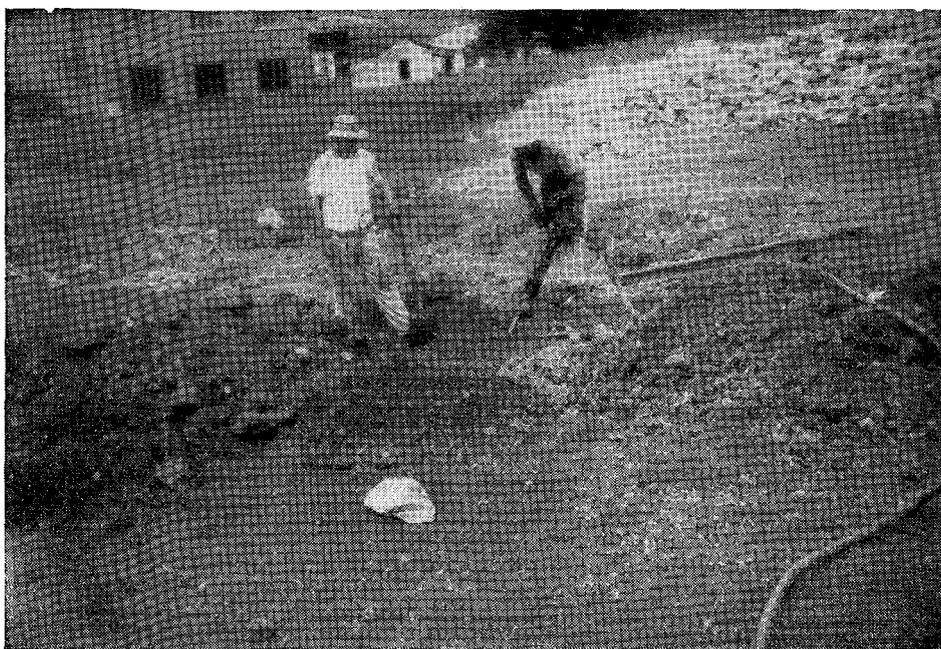
Fig n° 33<sup>a</sup> — Na topografia urbana de Pôrto Velho, o acesso da parte baixa da cidade — zona comercial para o bairro Caiari — parte alta, é feita vencendo-se uma rampa, a qual exigiu da Prefeitura o emprêgo de brocas mecânicas para cortar o laterito, como se vê na foto acima
