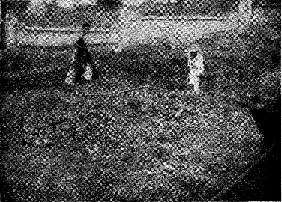
Fig. 4 — Trabalho executado pela Prefeitura de Pôrto Velho com perfuradores mecânicos, para conseguir o rebaixamento do declive ou mesmo cortar parte do barranco que constitui a cidade alta (especialmente o bairro Caiari). A canga é compacta, aparecendo no estágio final. É muito resistente ao choque do martelo ou da marrêta, porém, a perfuração é relativamente fácil com o uso da aparelhagem mecânica que vemos acima. (Foto do autor)
