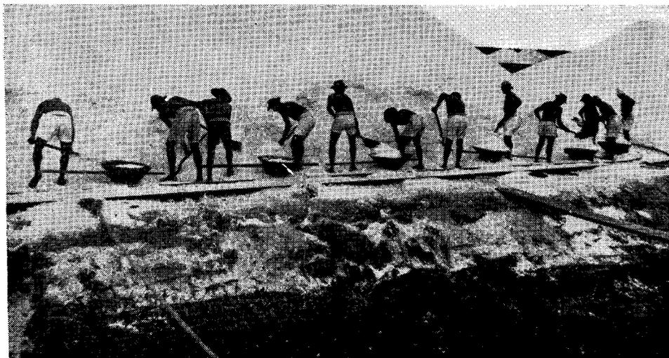
Foto 5 — Trabalho de transporte do sal do “atêro” para as barcas, à margem do rio Açú. O processo é rústico, empregam o “calão” — cesto de cipó — transportado por dois operários. (Foto do INS).
