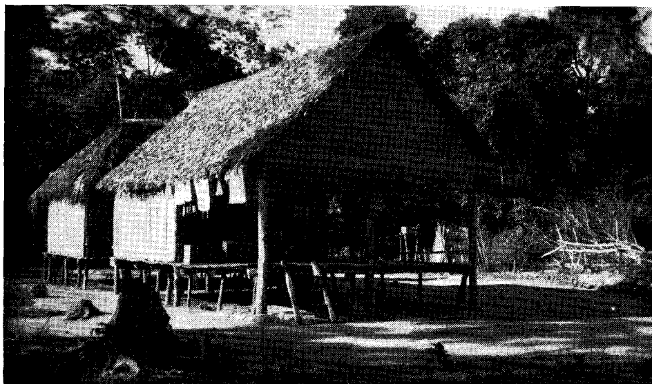
Fig. 20 — Casa de colono construída sobre estacas, vendo-se a cobertura e parte do alpendre fechados com folhas de palmeira. As paredes são de tábuas não aparelhadas e justapostas verticalmente uma ao lado da outra. O acesso à casa é feito pela pequena escada em frente ao alpendre onde o caboclo passa grande parte das horas de lazer. Foto tirada na colônia São Francisco. (Foto do Departamento Territorial de Imprensa e Propaganda do Acre).
