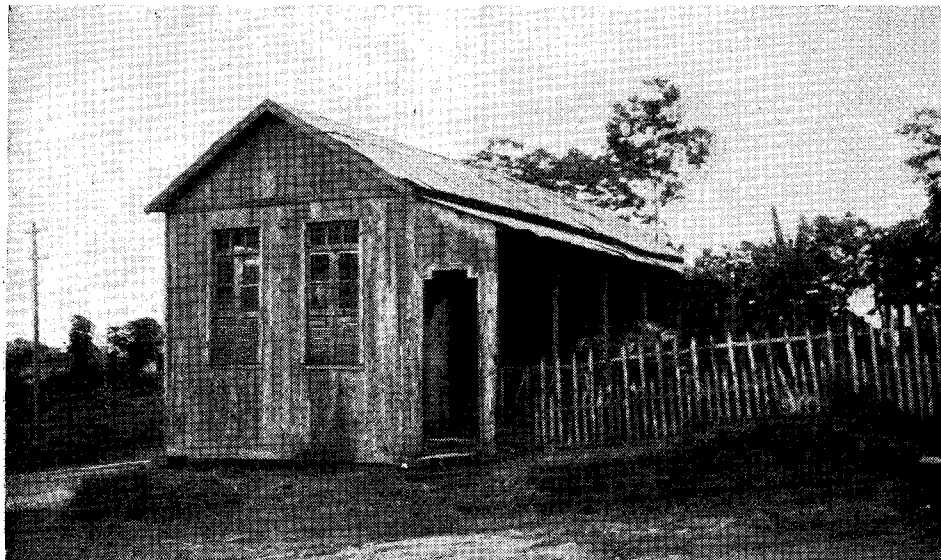
Figs. 14 e 15 — Dois tipos de “chalets” construídos de madeira, sendo o primeiro sôbre estacas de uns 2,50 m de altura, e o segundo ao rés do chão.
