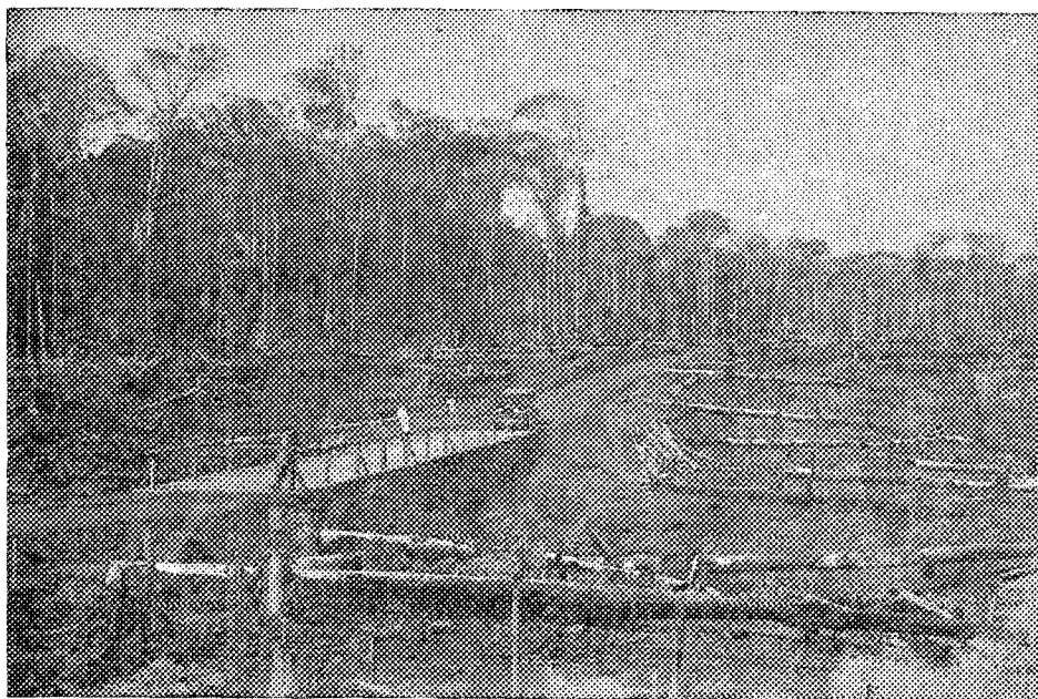
Fig. 18 — Rodovia "Centro-Oeste": trecho em construção entre Pôrto-Velho e Presidente Pena, no Território do Guaporé. Neste trecho a estrada está sendo aberta na floresta amazônica.
