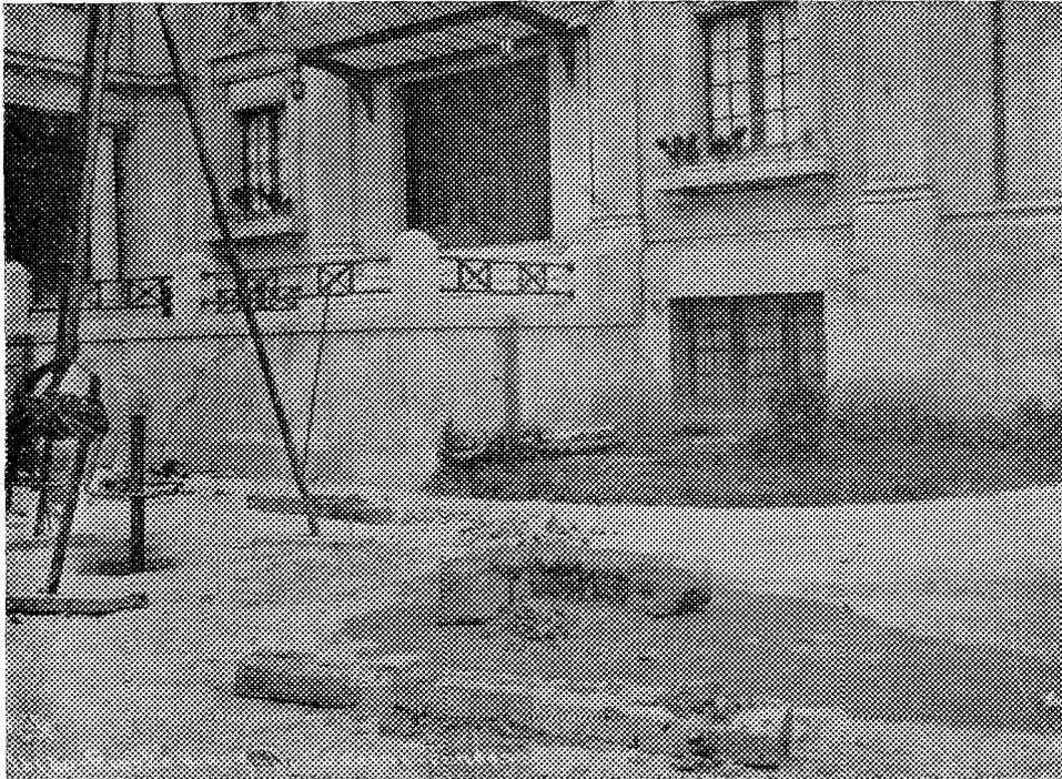
*Fig. 9 — Sondagens feitas no terreno onde foi construído o Teatro Cassino, a qual revelou grande quantidade de vaza a pequena profundidade. Vê-se no edifício uma fenda similar às inúmeras que existiam no interior do prédio.*
