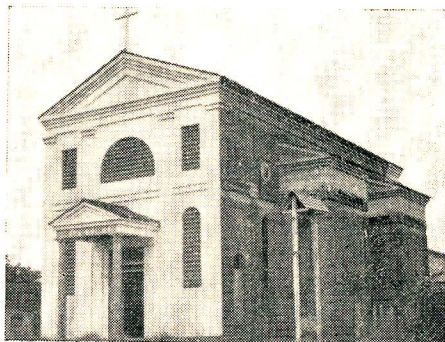
Igreja Matriz, em construção
