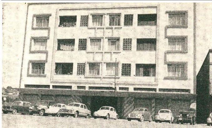
Fachada de um dos melhores hotéis da cidade
