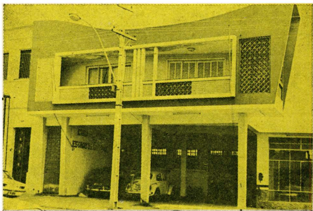
Caixa Econômica Estadual
