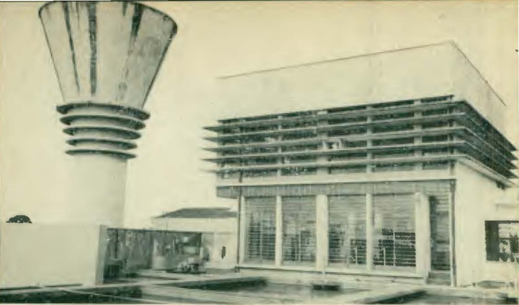
Estação de Tratamento de Água
