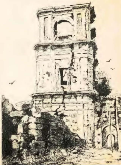
Templo de São Miguel — Torre antes da reparação
