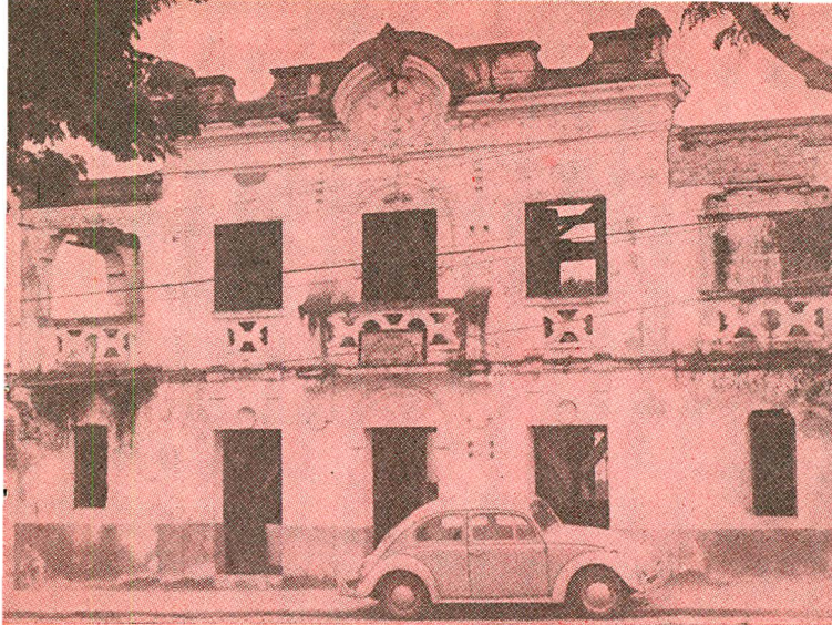
Fachada do Teatro João Caetano — ruínas
