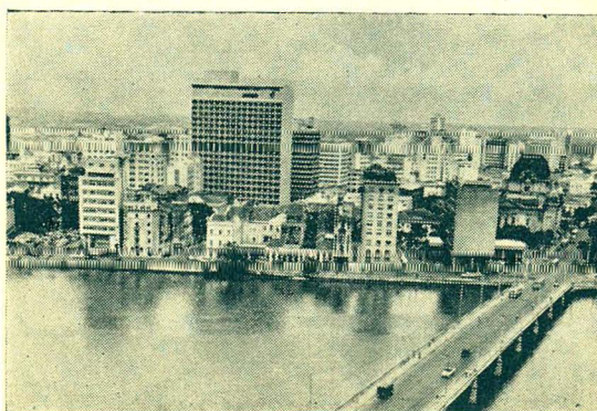
Ponte Maurício de Nassau
