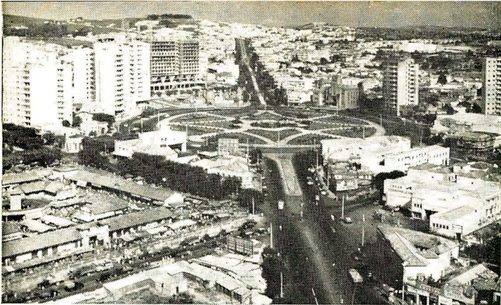
Vista (aérea) da Praça Raul Soares
