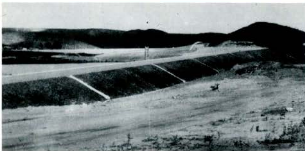
Barragem do Brumado
