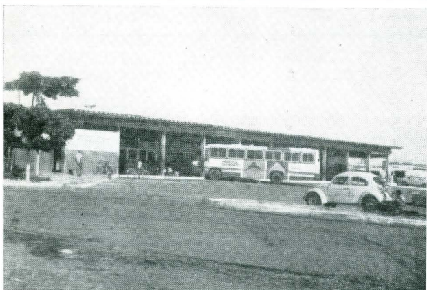
Estação Rodoviária Miguel Arcoverde
