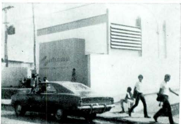
Estação Telefônica — TELEBAHIA
