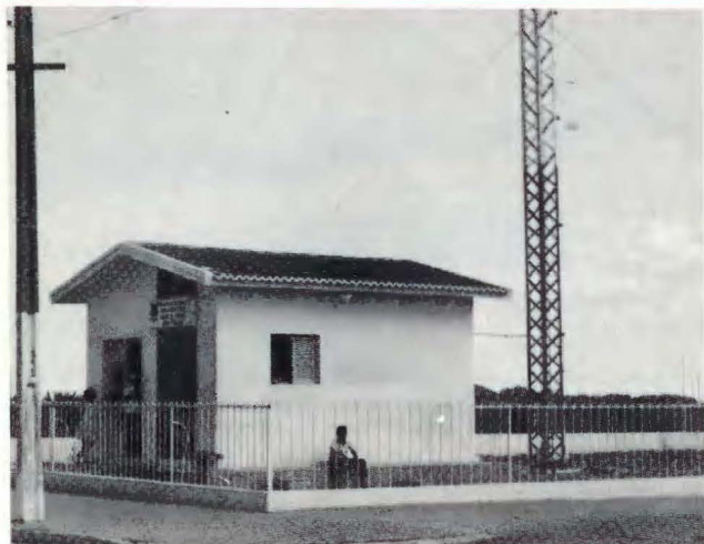
Posto Telefônico da TELPA
