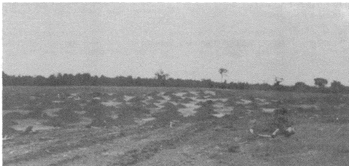
Foto 2 — Antes de iniciar-se a mineração, retira-se o solo para deixá-lo reservado e colocá-lo nas áreas em recuperação. Porto Trombetas. 1987.
