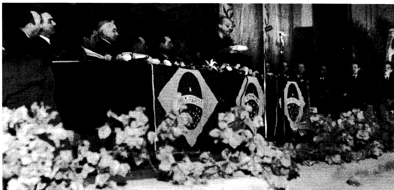
Com o objetivo de exaltar o significado histórico da construção de Goiânia, como primeiro marco real da Campanha da "marcha para o oeste", realizou-se no período de 17 de junho a 31 de julho de 1942 um conjunto de atividades culturais, denominado Batismo Cultural de Goiânia. Teixeira de Freitas promoveu e participou deste acontecimento cívico, pois acreditava que Goiânia constituía o primeiro passo para a interiorização da capital federal, e o Brasil, assim, passaria a ser efetivamente dono de si mesmo. Na foto, inauguração de Goiânia, onde Teixeira de Freitas discursou em nome do Presidente da República Getúlio Vargas. Goiânia, 5 de julho de 1942.
