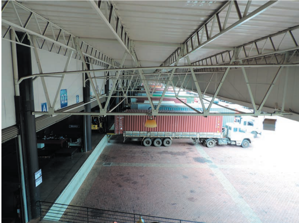
Pátio de caminhões porta contêineres, Município de Varginha (MG). Emílio Reguera, 2015.
