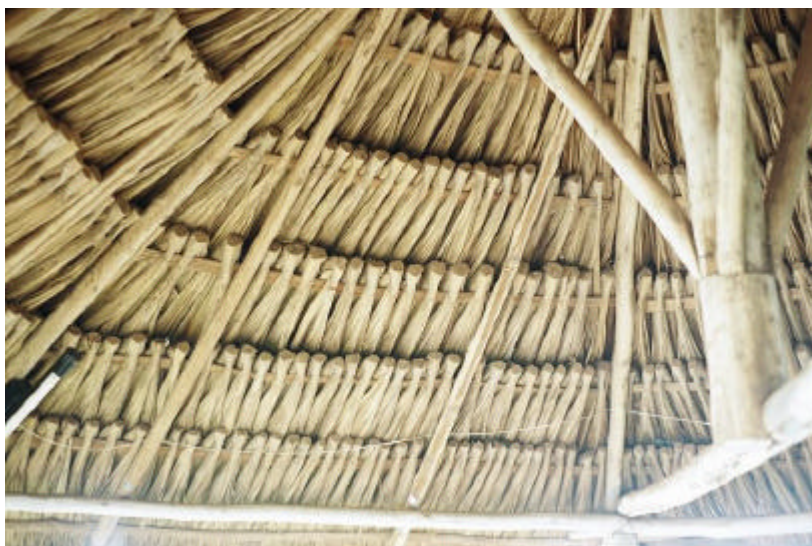
Foto 20 - Uso da folha do buriti como palha para cobertura dos telhados e o tronco como esteio e vigas.
