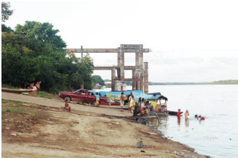
Foto 29 - Porto inacabado – Rampa do porto de Caracaraí sobre o rio Branco e estrutura inacabada do novo cais.
