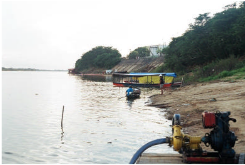
Foto 28 - Terminal de óleo – Rampa do porto de Caracaraí sobre o rio Branco e terminal de derivados de petróleo da PETROBRAS
