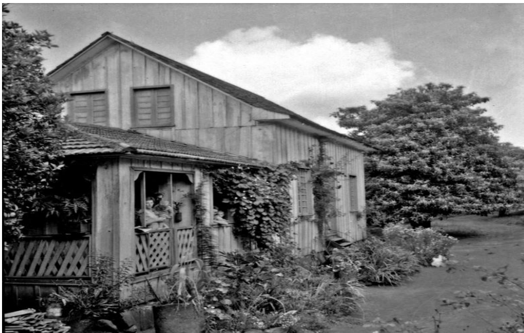
Figura 3 – Casa de colono de origem italiana no município de Xaxim (SC). 1965
