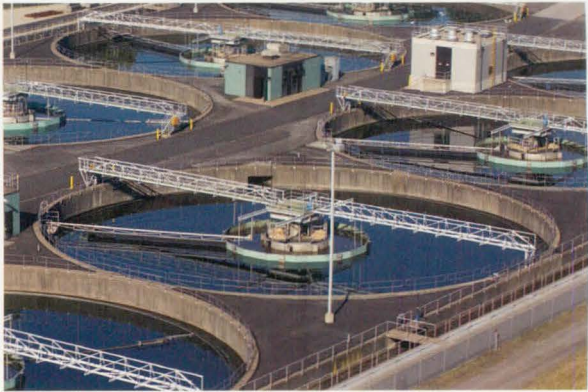
Estação de tratamento de água
