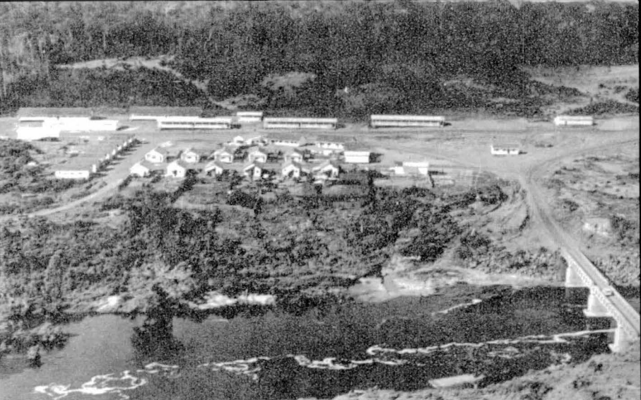
Canteiro de Obras e Casa de Fôrça, em construção, da Hidrelétrica de Curuá-Una, em Santarém.
