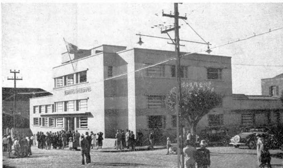
Correios e Telégrafos de Ponta Grossa
