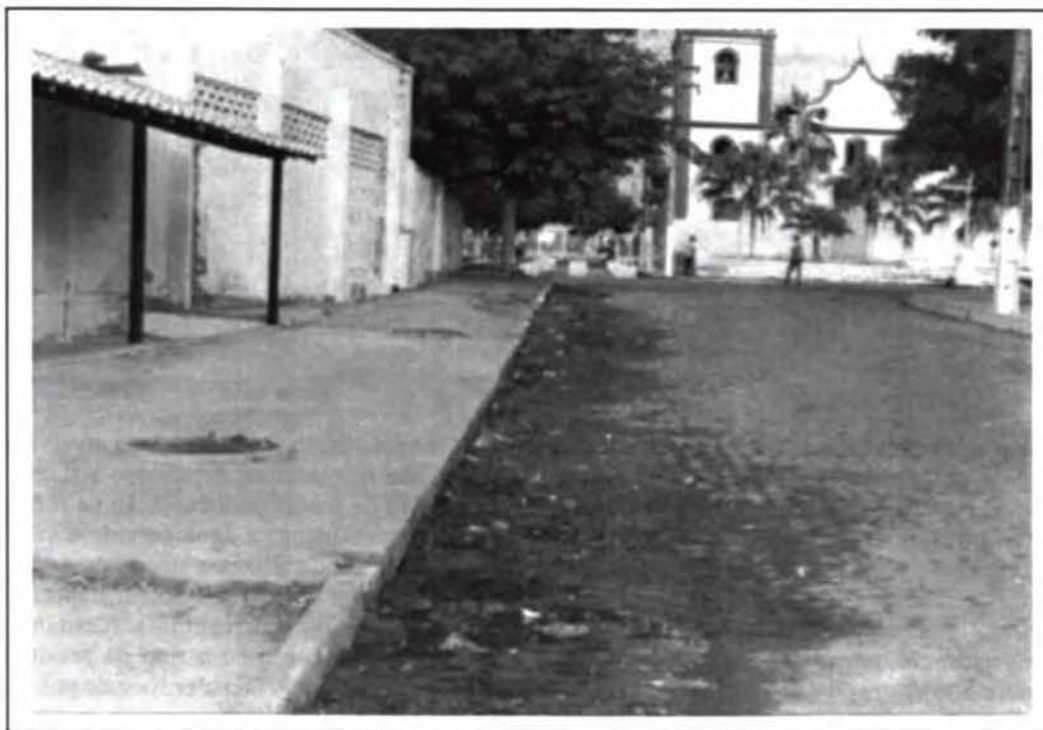
Foto 11 - Esgoto doméstico lançado na via pública - Cidade de colinas.
