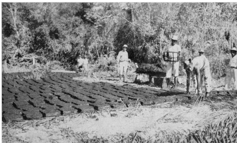
*Fig. 60 — Briquetagem rudimentar da turfa em Cabiúnas.*
