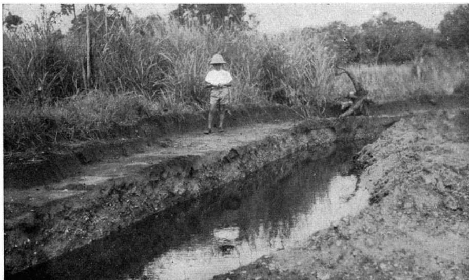
**Fig. 61** — *Jazida de areia de fundição em Macaé. Nota-se o depósito sob a camada de argila negra parcialmente removida.*
